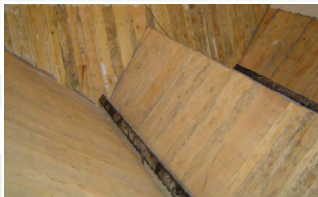
Detalle de la estructura de soporte del pellet un el silo y tomas storz 110 de llenado del silo.
