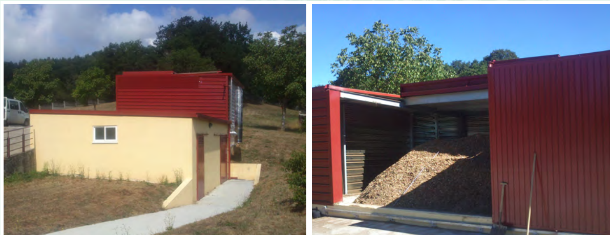
Edificio de sala de calderas y silo ampliado.
