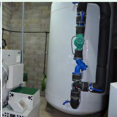
Izq: Multiciclones, caldera y alimentador de combustible. Dcha: Depósito de inercia.
