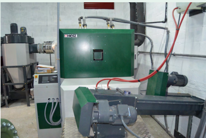
Izq: Multiciclones, caldera y alimentador de combustible. Dcha: Depósito de inercia.
