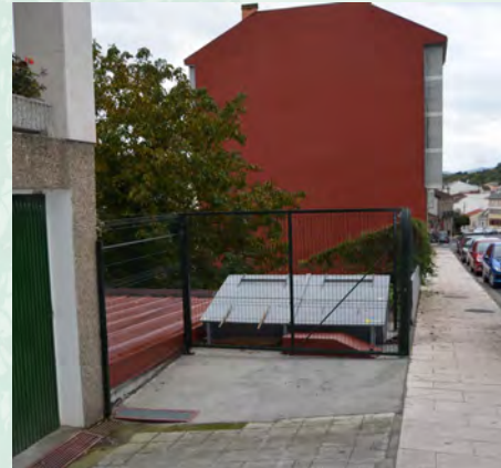
Acceso a la tolva de descarga.
