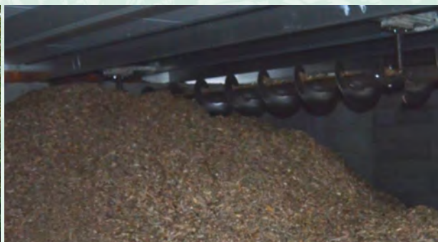
Nueva construcción que alberga silo y sala de calderas. Dcha: Sin fin de reparto de astilla.
